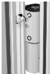
» Gewindestifte mit einer 1/2 Umdrehung lösen.
